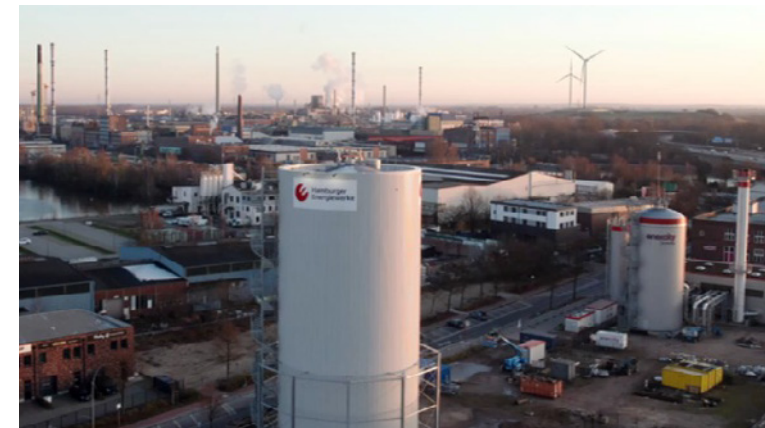
Warmwasserpufferspeicher der Hamburger Energiewerke
