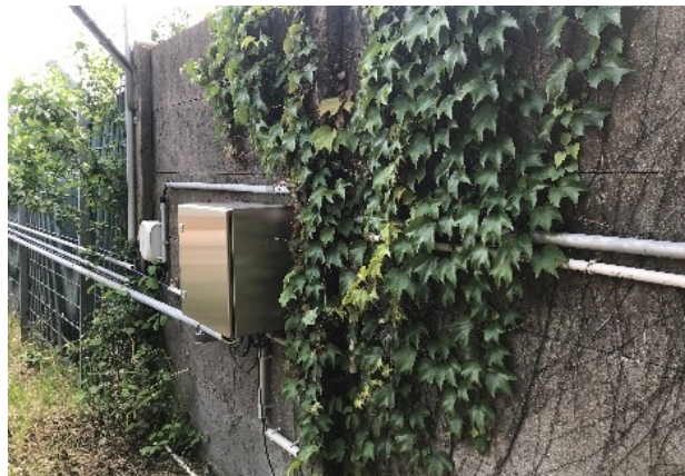
Begrünte Wände und Werksmauern
