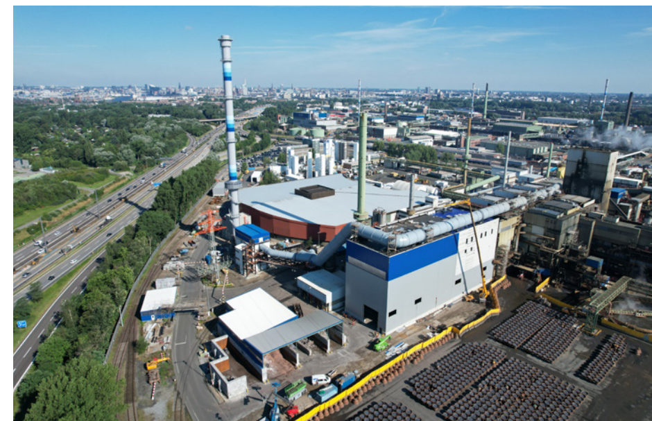
Blick auf das neue Abluftsystem am Standort Hamburg in unmittelbarer Stadtnähe
