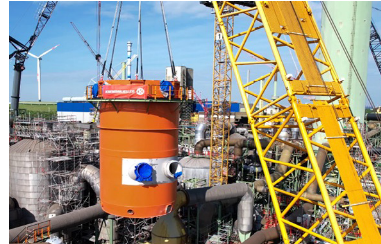
Umbau der Kontaktanlage im Industriewärmeprojekt
